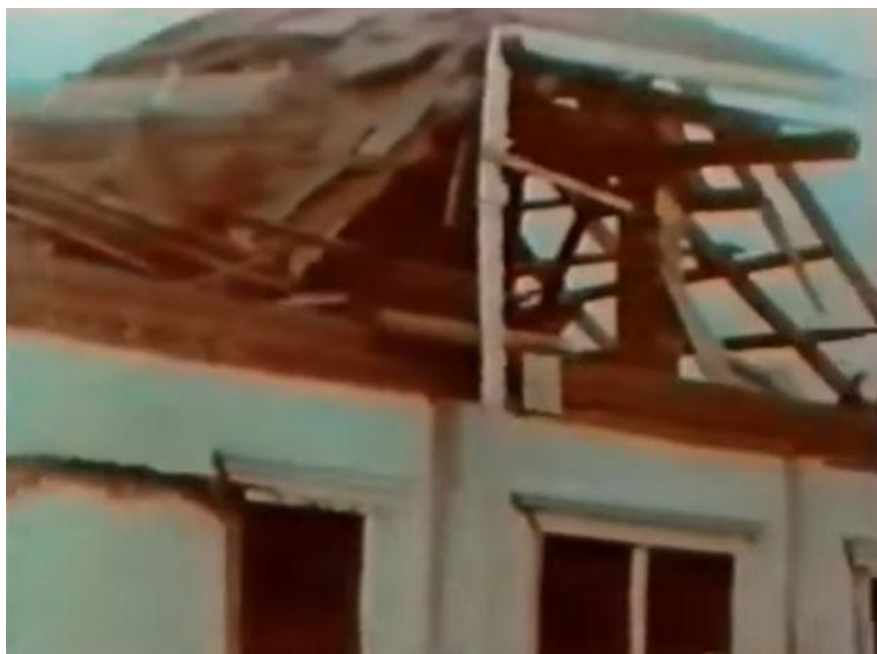
Рис. 12 – Разрушения дома испытателей Семипалатинского полигона [28]
