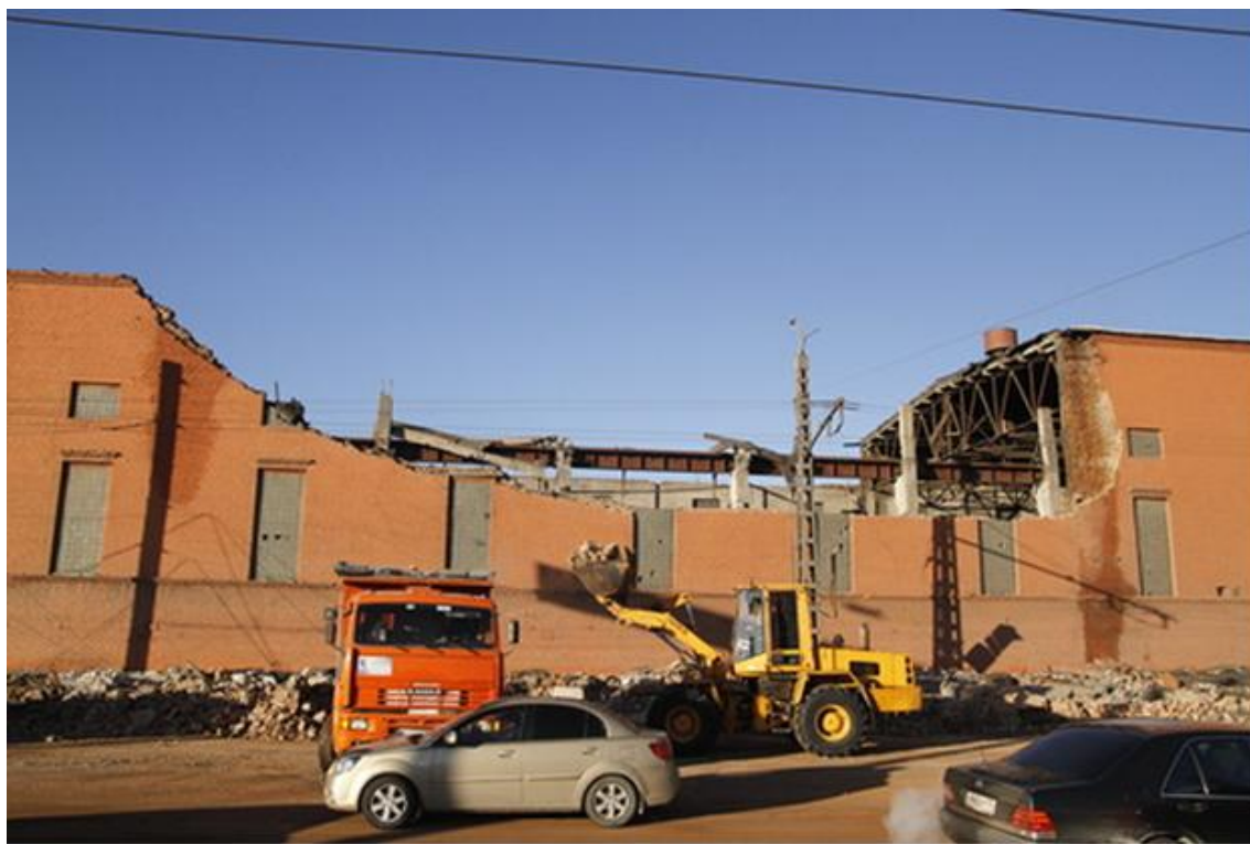
Рис. 3 – Разрушение капитального здания Челябинского цинкового завода ударной волной
